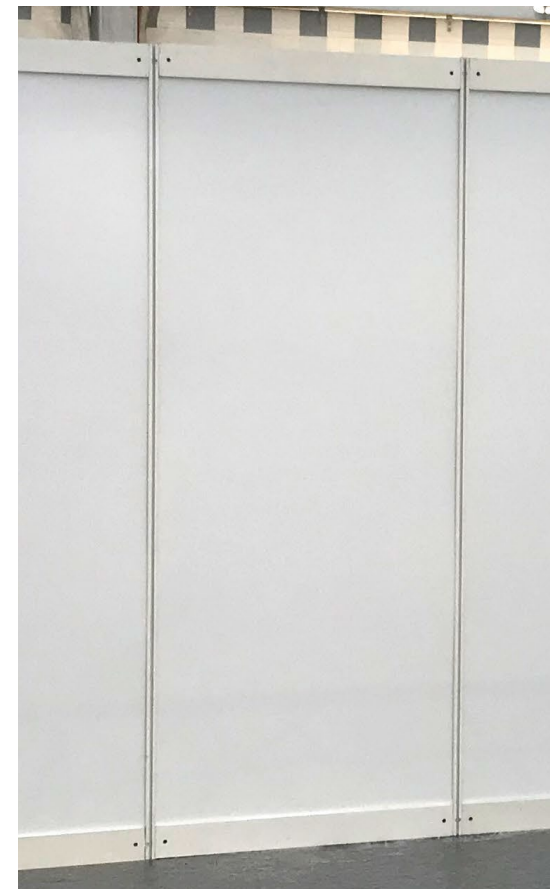
Systemwand im Einsatz
